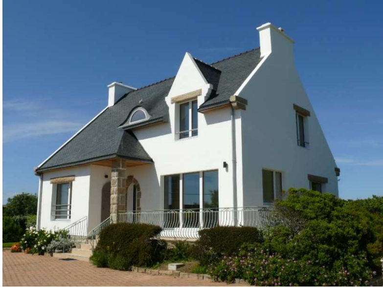
Façade sud après travaux de rénovation
