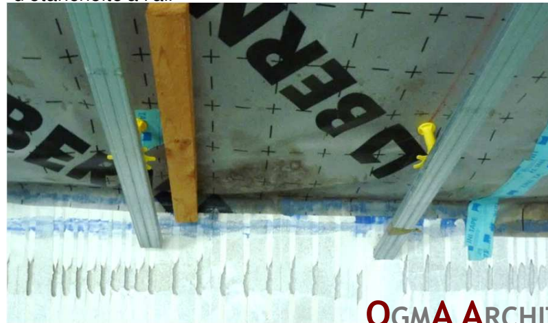
Défaut d'étanchéité à l'air : absence de continuité de la couche d'étanchéité à l'air
